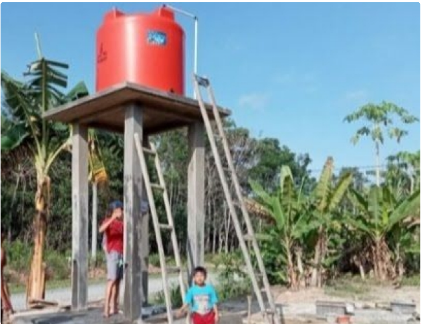
Pembangunan sumur bor di Desa Fajar Baru
