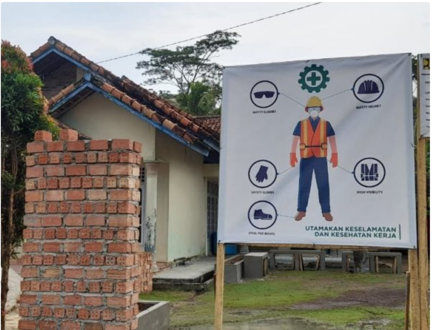
Proyek Infrastruktur Hunian Hijau di Mesuji
