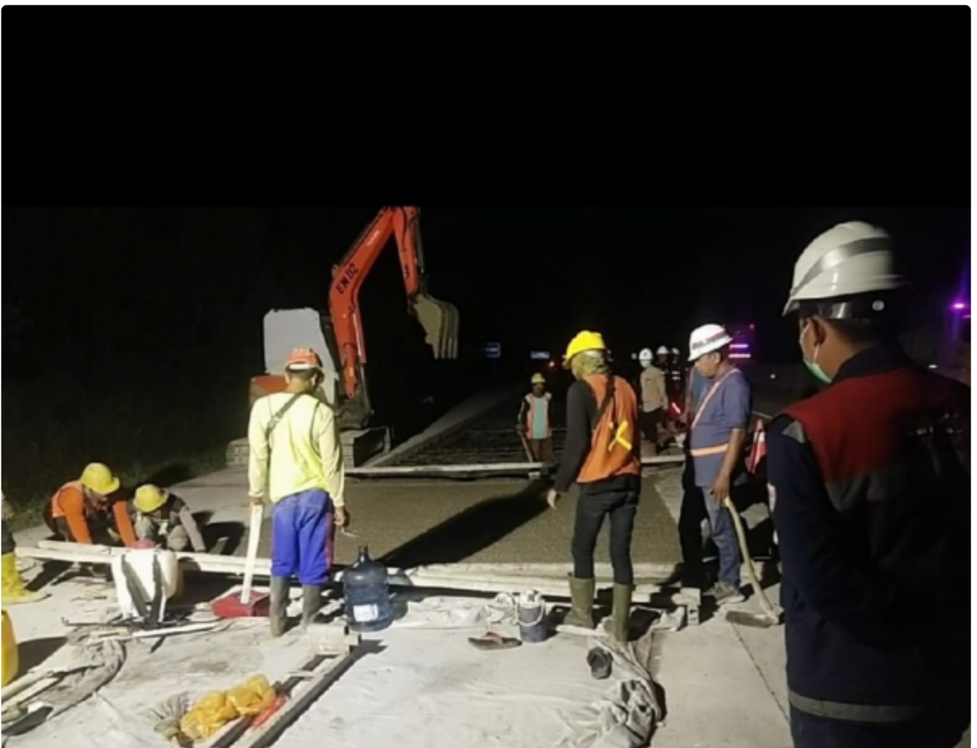
PT HKI Perbaiki Tol Terbanggi Kayu Agung
